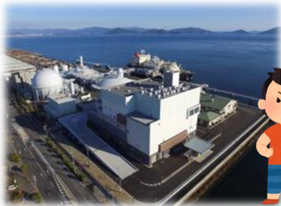
はつかいちエネルギークリーンセンター
